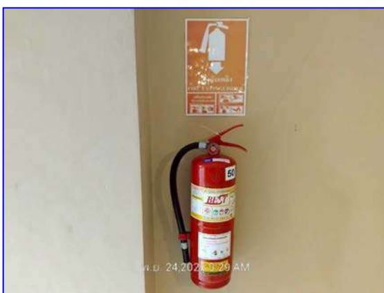
รูปที่ 2.25 ถังดับเพลิง และตู้เก็บสายดับเพลิง
