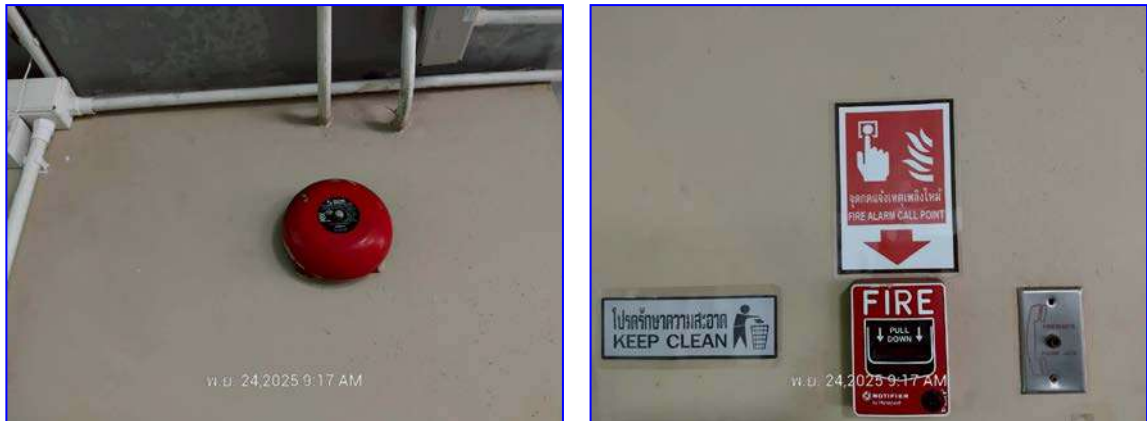
รูปที่ 2.44 สัญญาณแจ้งเตือนเหตุเพลิงไหม้
