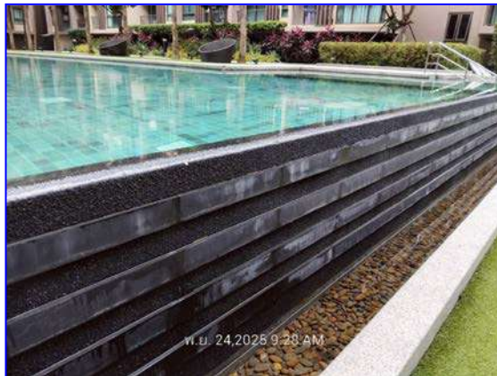
รูปที่ 2.38 รางระบายน้ำล้น และแสงสว่างบริเวณสระว่ายน้ำ
